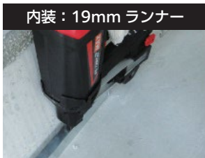
内装ランナー留め付け
