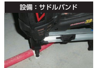
サドルバンド留め付け
