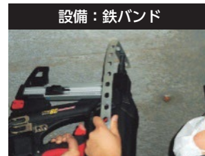
鉄・樹脂バンド留め付け
