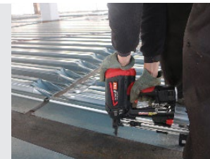
デッキプレート留め付け
