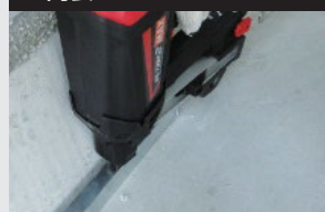
内装ランナー留め付け
