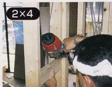
ころび止め打ち
