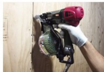
より面一精度が求められる壁施工
