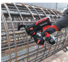
場所打ち杭 鉄筋かご 3層組 D32×D32×D13
