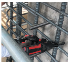
土木工事 橋梁 補強工事 D38×D22
