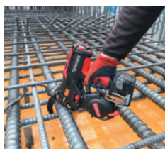
土木工事 橋梁 梁 D51×D25
