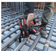
土木工事 橋梁 フーチング D51×D32
