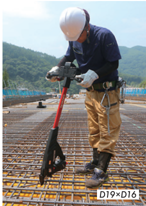
橋梁RC床版
