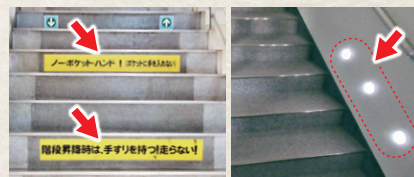
同研究所では、転倒災害防止にも力を入れている 【左】ポケナンを励行するための注意表示 【右】階段を人が通ると点灯する人感センサーライト
