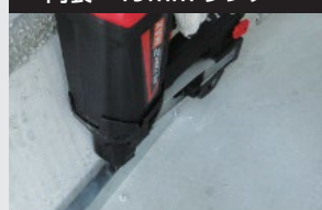
内装ランナー留め付け
