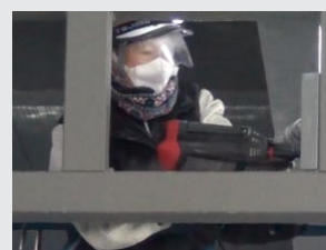
C形鋼、角形鋼への 内装ランナー留め付け
