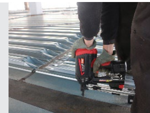
デッキプレート留め付け
