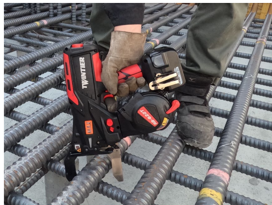
鉄筋結束機 特大径モデル 「ツインタイヤ RB-822T」新製品
