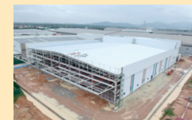
建設中のタイワイヤ生産工場
