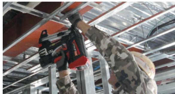
コードレス ガス内燃式ピン打機「ガスネイラ」
