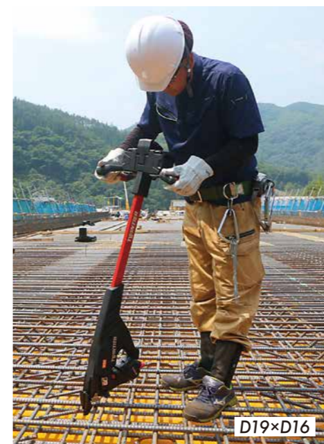
橋梁RC床版
